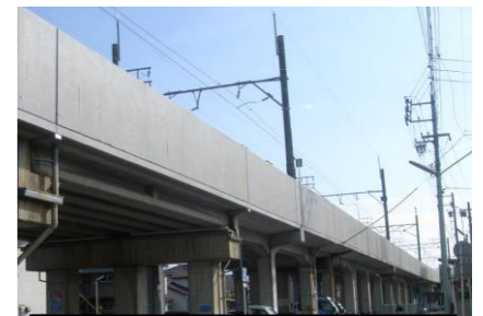
名古屋鉄道：高架橋
